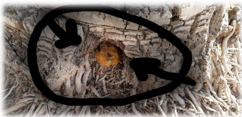
شکل ۳: ساختار در حال ترمیم
