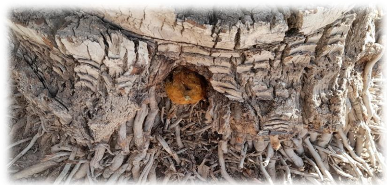
شکل ۴: ساختار در حال ترمیم
